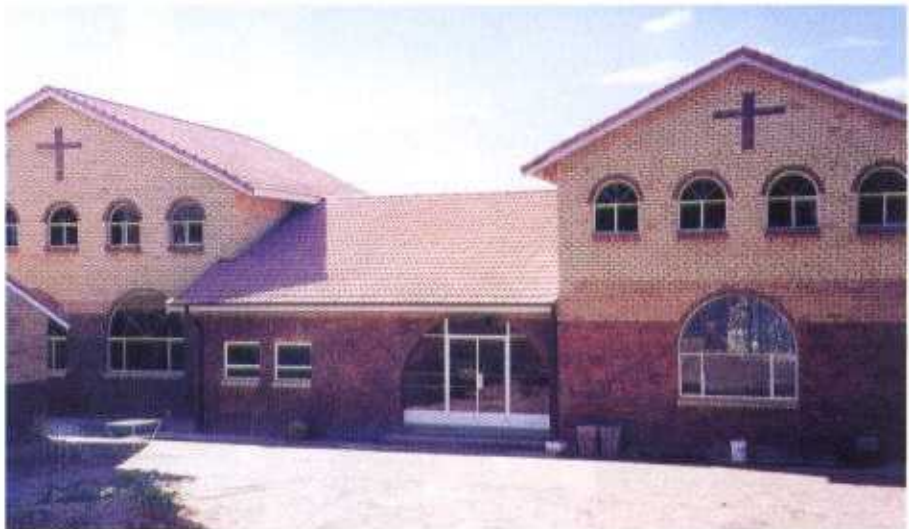
مبنى المعهد اللاهوتي وبه قاعات للمحاضرات كما به أيضاً دور علوى لإقامة الرجال والسيدات منفصلين وبه أيضاً منافع لأهله
